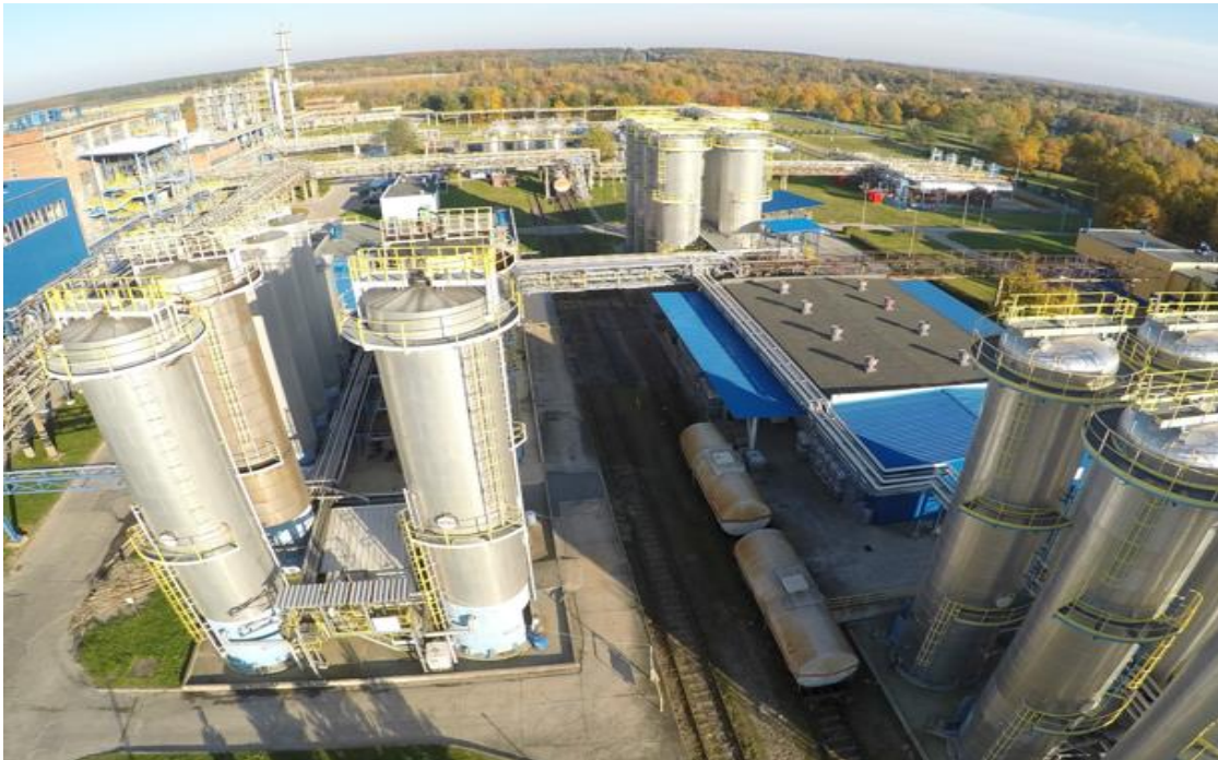
Kompleks Rokopole Instalacje produkcyjne polioli
