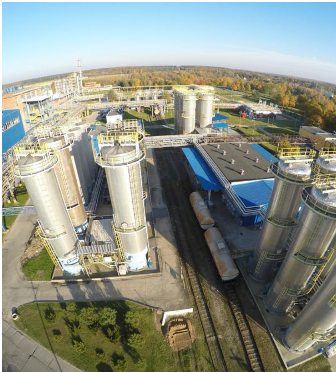
Kompleks Rokopole Instalacje produkcyjne poliole
