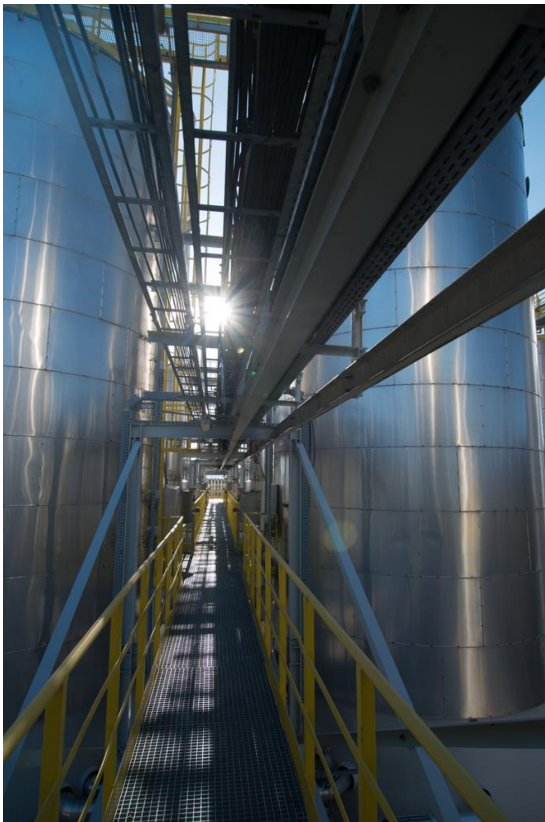
Instalacja Siarczanowane II w Brzegu Dolnym
